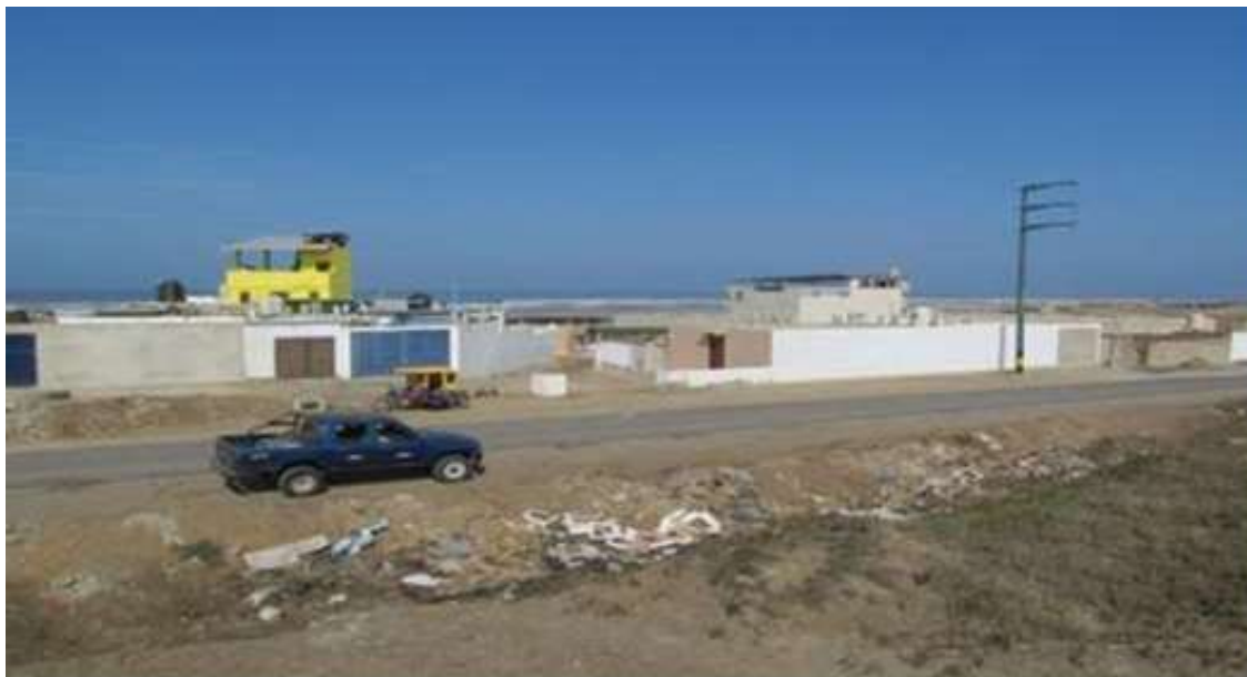
Fig. 51. Prolongación y corte de la Huaca El Charco por la carretera Costanera que en su lado sur se arrojan basura y desmonte. (Foto J. Cárdenas A.).
