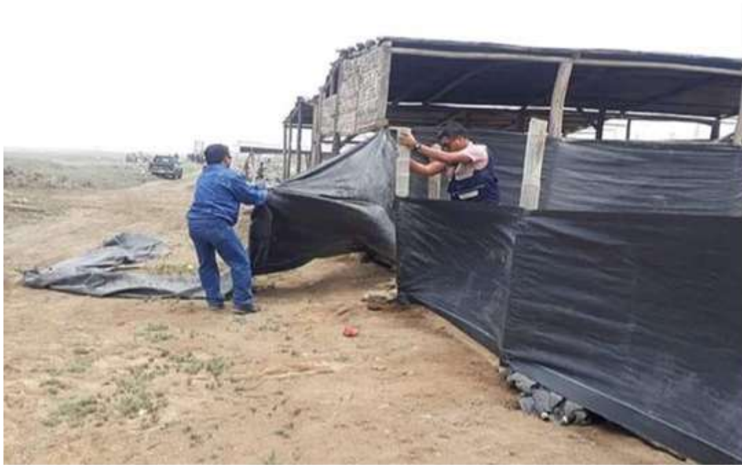
Fig. 58. Intervención de desmantelamiento de ambientes preelaborados instalados sobre superficie de relleno y desmonte sobre el lecho del Humedal El Charco.
