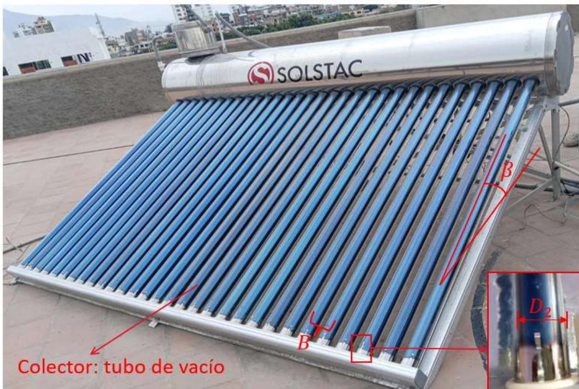
Figura 1. Arreglo de tubos al vacío en una terma solar
