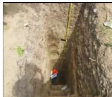
Figura 10. Vista de las Calicatas realizadas en la Zona III – Trujillo. (Prolongación Gonzales Prada – Trujillo).
