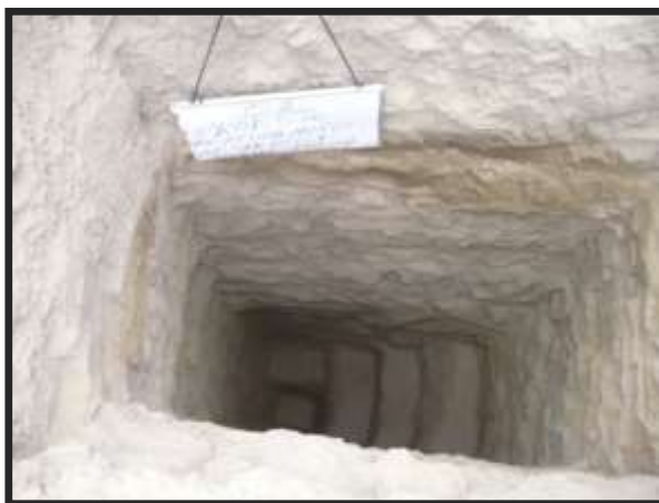
Figura 5. Vista de las Calicatas realizadas en la Zona I – Trujillo. (Av. Pedro Muñoz – Trujillo).
