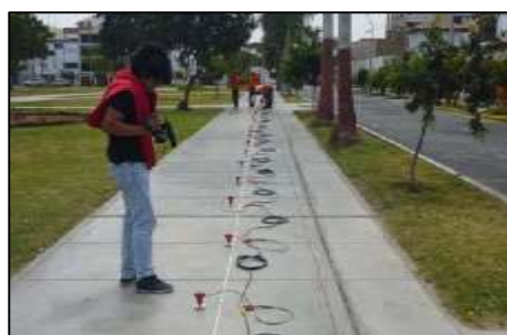
Figura 13. Vista de Ensayos MW-1 en el Distrito de Trujillo (Urb. El Recreo - Trujillo).
