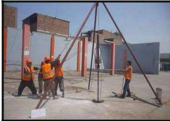
Figura 4. Vista del Ensayo de Penetración Estándar (SPT), en el Centro Comercial Plaza Vea - Av. España.
