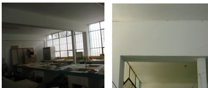
Fig. 4-2. Reforzamiento de los pórticos del pabellón 1B.
