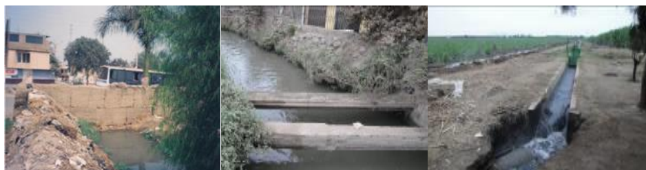
Fig. 05. Canal de Regadío para Cultivo de Caña de Azúcar con efectos contaminantes en Laredo.
