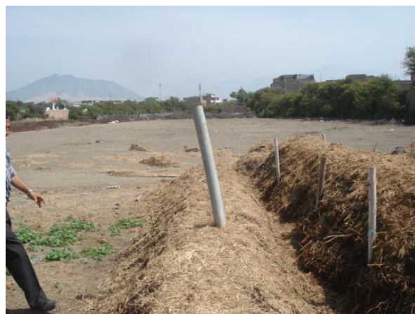
Armado de una pila de capas superpuestas de: restos de áreas verdes, frutas, estiércol de cuy y cachaza. Colocación de tubos de pvc 2” de diámetro dentro de la pila, para permitir liberación de gases producto de la descomposición.
