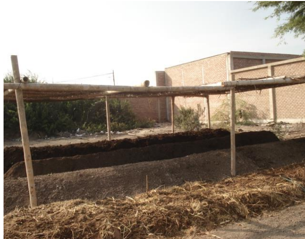
Armado de una estructura de madera que proteja a las pilas de compost de los rayos solares evitando una excesiva evaporación.
